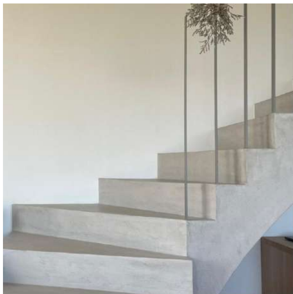
CEMENTOVÁ STĚRKA NA SCHODIŠTI
