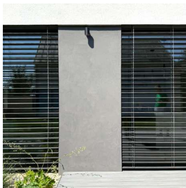
ZASUNUTÁ OMÍTKA MEZI OKNY - ŠEDÁ
